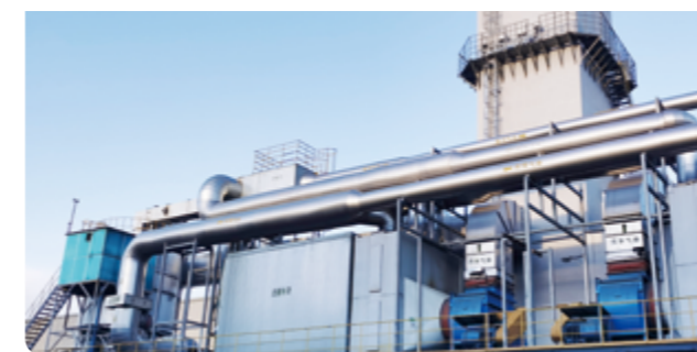
RTO 余热设施改造
